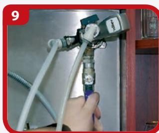
**9** Закройте клапан подачи воды и отсоедините заборную головку от промывочного адаптера.
