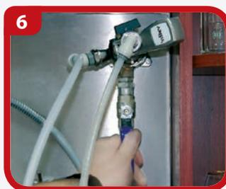
**6** Откройте клапан подачи воды на водопроводе.
